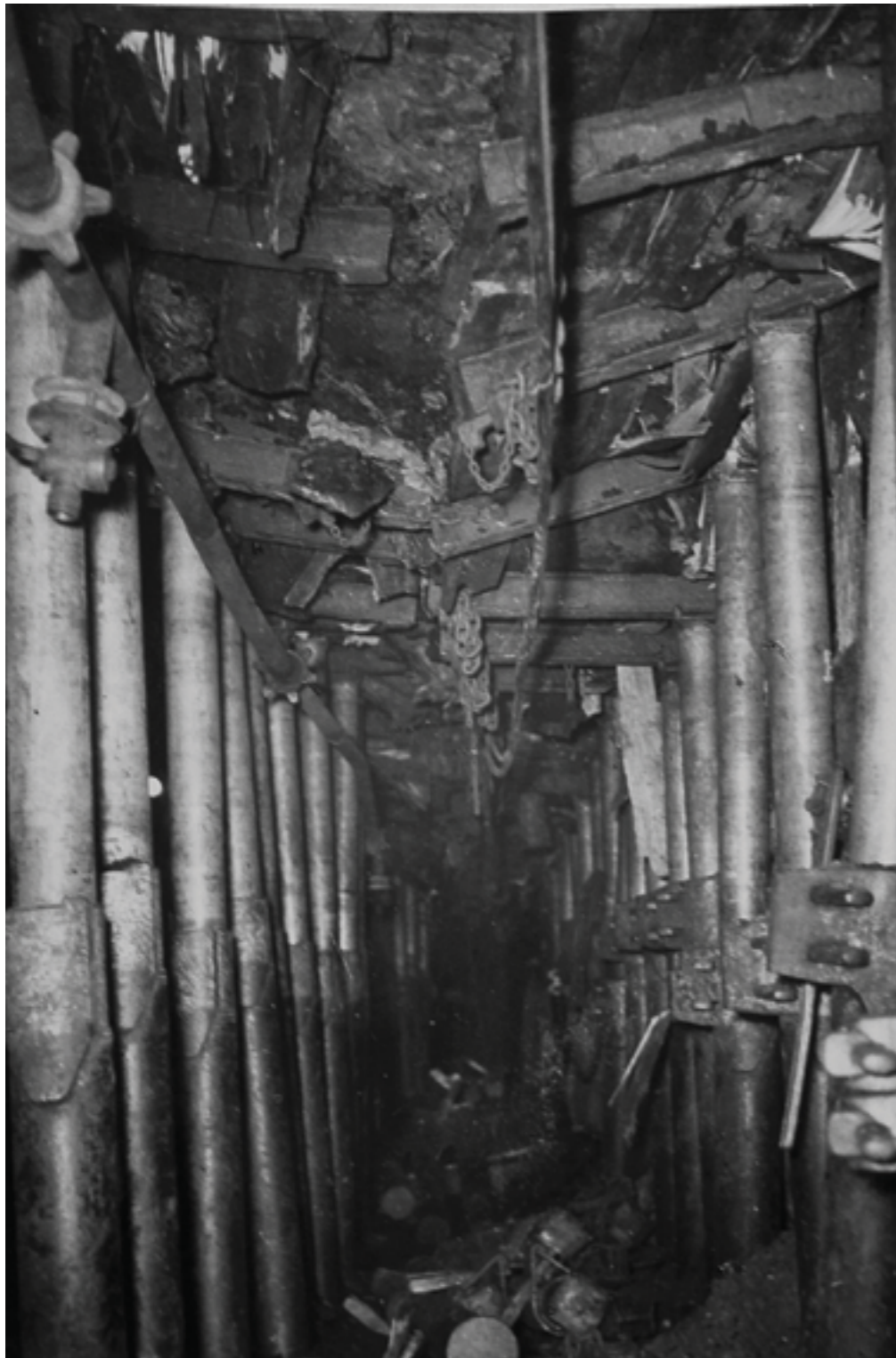
Jeklene jamske stojke tipa Valent vgrajene v rudnik rjavega premoga Trbovlje - Hrastnik. Arhiv ZAC
